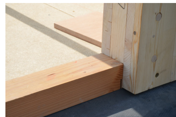
Aansluiting paneel op de ringbalk/stellat.
