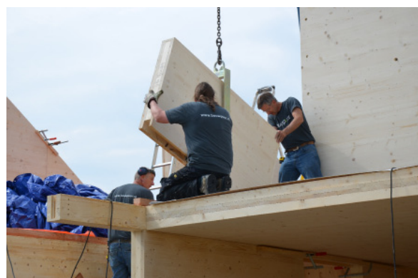
Plaatsen van een binnenwandpaneel op de verdieping.
