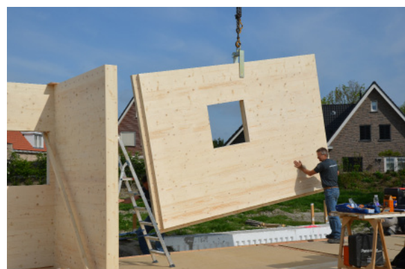
Plaatsen van een gevelpaneel op de begane grond.
