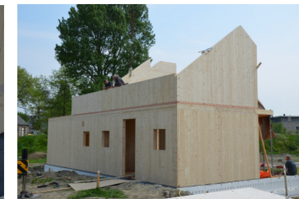
In de andere gevels – op het noorden – is in de ruwbouw fase méér hout zichtbaar.
