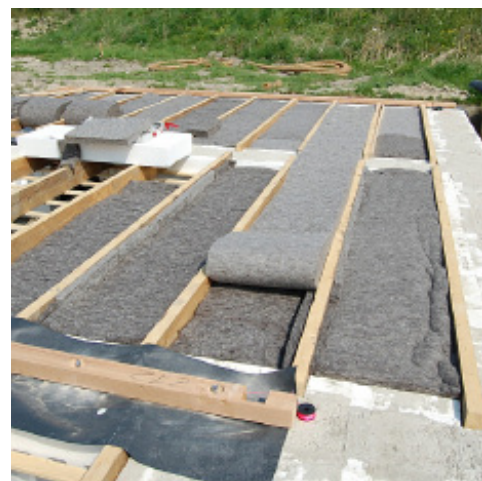
Begane grondvloer, geïsoleerd met schapenwol.
