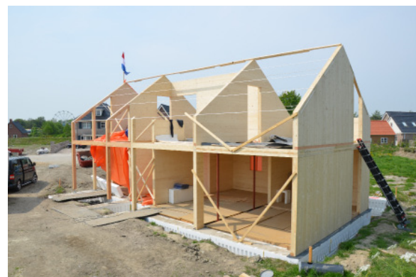
Alle Nur-Holz panelen zijn geplaatst; de vlag kan in top. Dit is de open zuidzijde.
